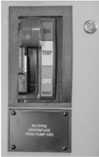
Figure 29. On ne peut ouvrir la porte lorsque le sectionneur est en position ON
