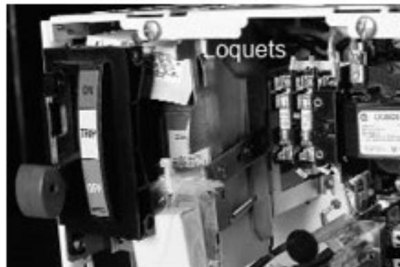
Figure 25. Dispositif de déconnexion à la position OFF. Deux loquets quart de tour sont situés dans le haut du tiroir.
