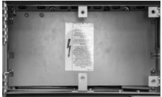
Figure 3. Les CCMs résistants aux arcs sont munis d'un écran métallique
