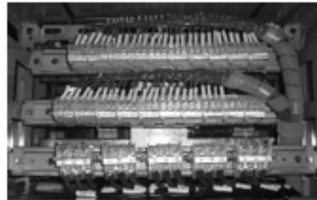
Figure 19. Bornier maître type C typique dans le haut d'une section
