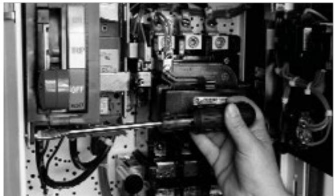
Figure 31 Retrait de la vis de fixation fixant la base de la manette sur le côté de l'unité
