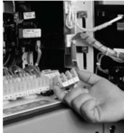
Figure 22. Montage des blocs de jonction
