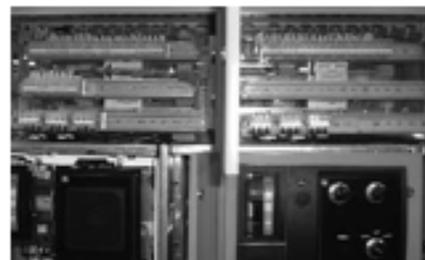
Figure 20. Bornier maître type C typique dans mul-tiples sections
