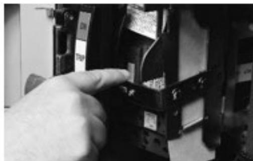
Figure 27 Fonction de verrouillage de porte qui empêche l'accès à la déconnexion lorsque le système est sous tension
