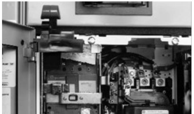
Figure 32 . Faire pivoter la manette de commande pour accéder au disjoncteur
