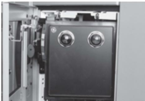
Figure 34A Support des dispositifs pilotes métallique pour CCMs résistants aux arcs
