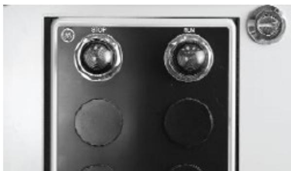
Figure 34A Support des dispositifs pilotes métallique pour CCMs résistantes aux arcs
