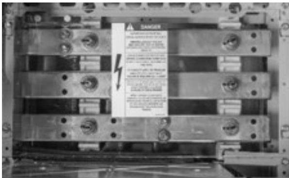
Figure 11. Barres horizontales avec écran en Lexan
