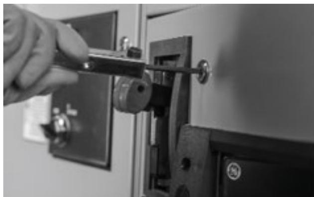
Figure 28. Vis cachée pour déjouer le verrouillage de la porte
